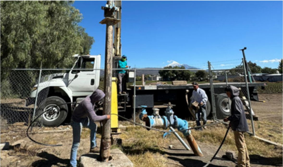
Ilustración 1. Adquisición e instalación de bombas y equipamiento para el mantenimiento de pozos en Palmar de Bravo mediante el Fondo FORTAMUN 2024 1
