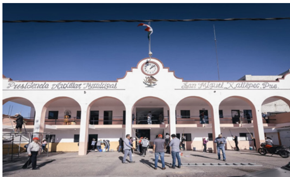
Ilustración 22. Rehabilitación y pintura de la fachada de la Presidencia Auxiliar de San Miguel Xalpetec
