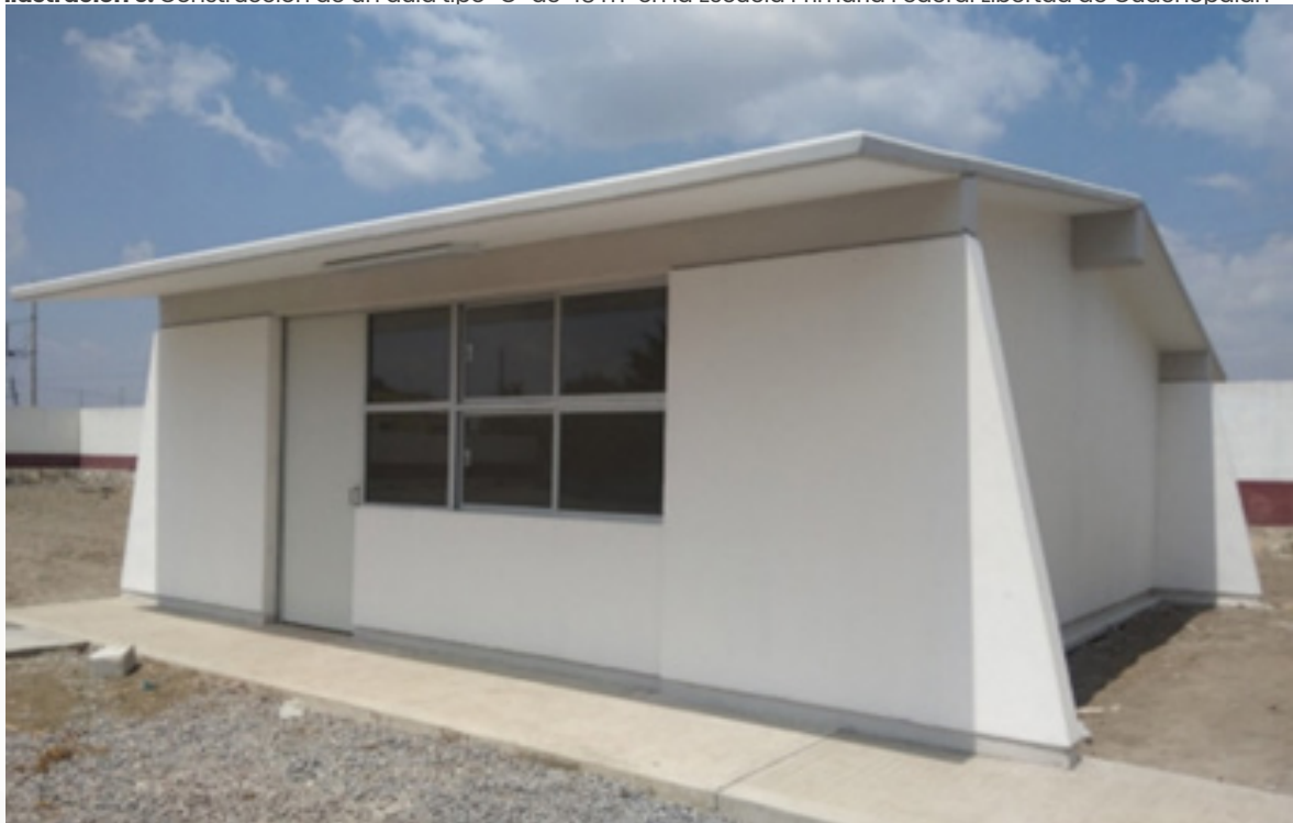
Ilustración 6. Construcción de un aula tipo "C" de 48 m 2 en la Escuela Primaria Federal Libertad de Cuacnopalan 5
